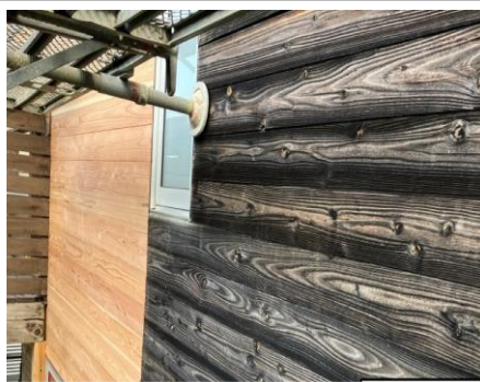
外壁工事：木工事
