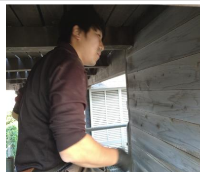
外壁工事：施工前
